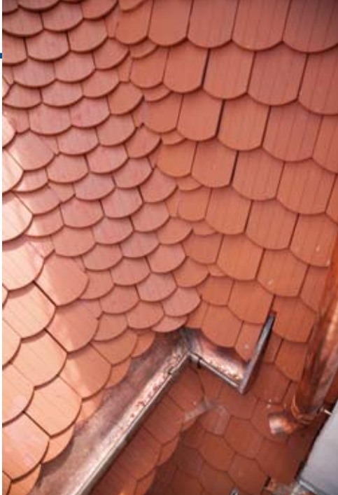
Die Kehlen wurden in der Art einer „Böhmischen Kehle“ eingedeckt.
