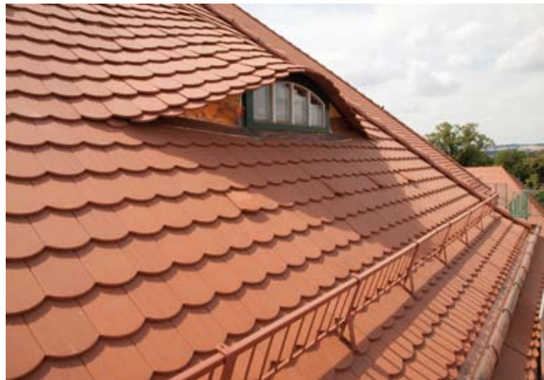
Die Fledermausgauben sind schwungvoll in die Dachfläche eingebunden.
