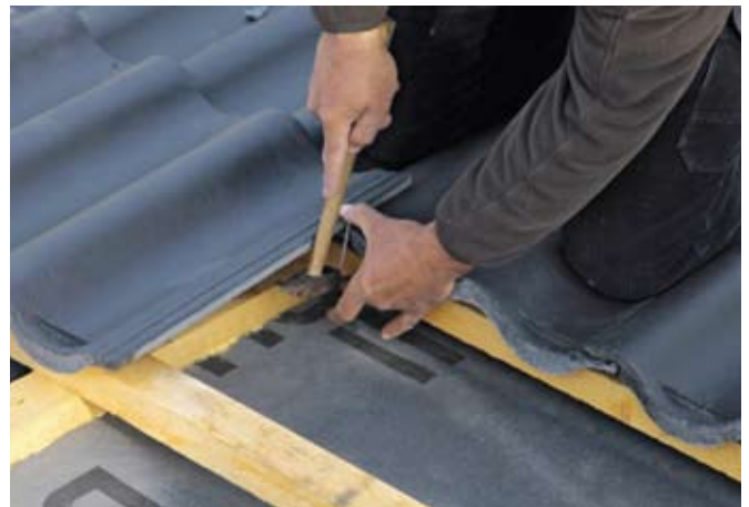
Die Windsogsicherung erfolgt in der Fläche mit der abgestimmten Sturmklammer.
