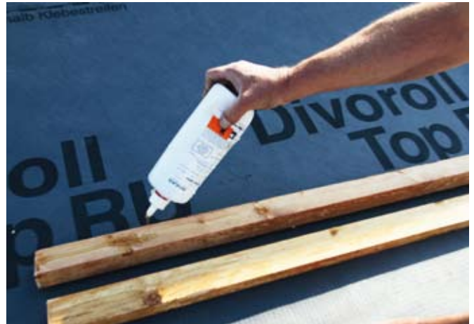
Die Nageldichtmasse schäumt zwischen Konterlattung und Bahn auf und dichtet ab.
