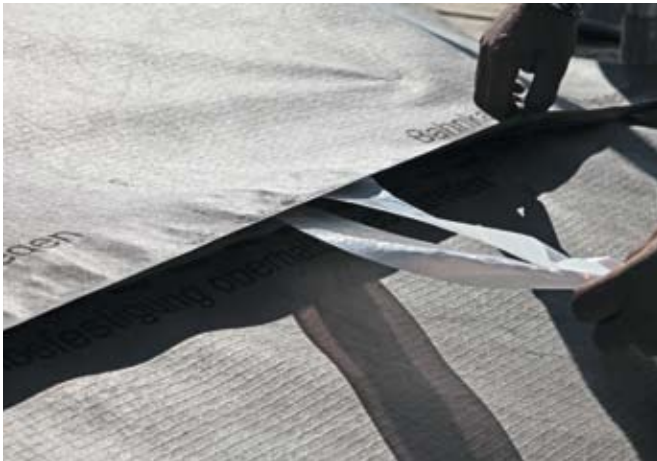
Für die sichere Verlegung der Unterkonstruktion ist die Doppelklebezone entscheidend.
