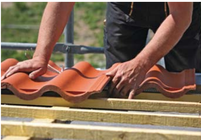
Die Regensperre des Betondachsteins verbessert die Regensicherheit.
