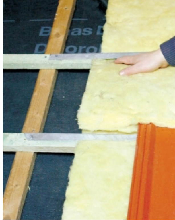
↑ Dämmschichtstücke als 2. Lage firstseitig unter Metallwinkel gedrückt.
