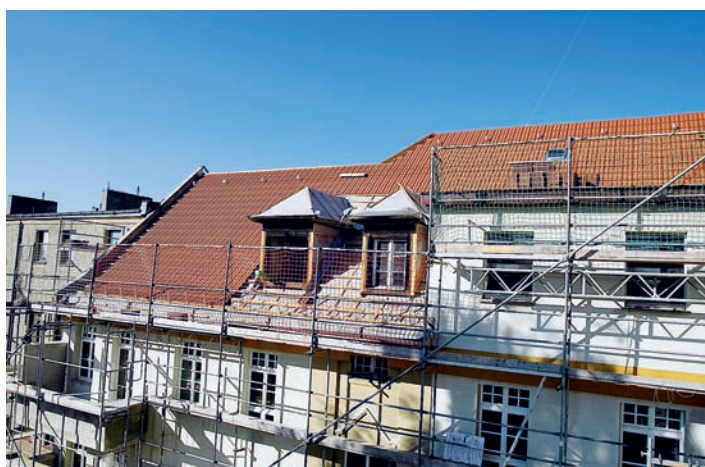
Dachdeckungs- arbeiten auf einem Wohnhaus der Schwartz- kopff-Siedlung in Wildau.
