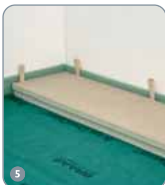
Randstreifen-Verlegung, Distanzkeile
