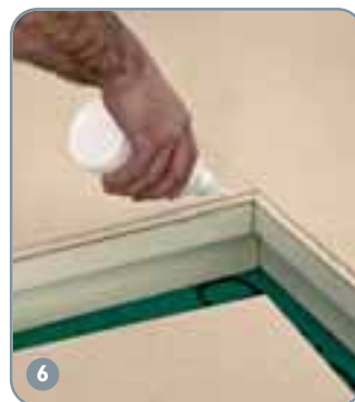
Verklebung Stufenfalz der Holzwerkstoffplatte
