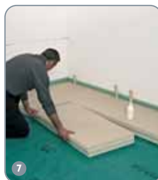
Verlegebeispiel Stoßversatz ca. 1/2 Plattenlänge
